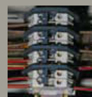
Dérivation sur blocs Viking par peigne de liaison équipotentielle sécable réf. 394 21
