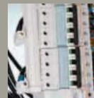
Peigne tripolaire Lextic réf. 049 42 pour répartition triphasée
