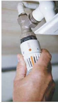
Grâce à un robinet thermostatique, vous pouvez limiter ou couper l'arrivée d'eau chaude et réguler votre chauffage.
